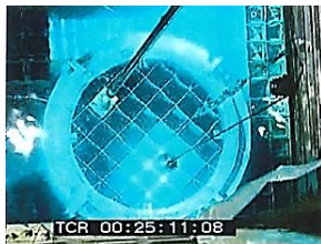
図 3 使用済燃料の取出し；キャスクへの装荷、ISFSI への移送、定置
