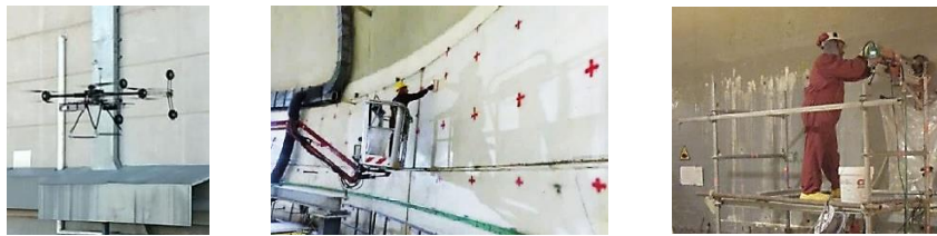
図 9 ドローンによるサーベイと除染作業
