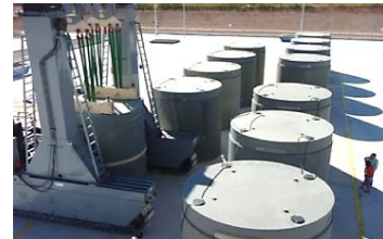
図 3 使用済燃料の取出し；キャスクへの装荷、ISFSI への移送、定置
