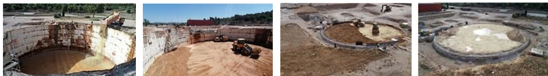
図 13 格納容器建屋跡地の埋め戻しの経過
