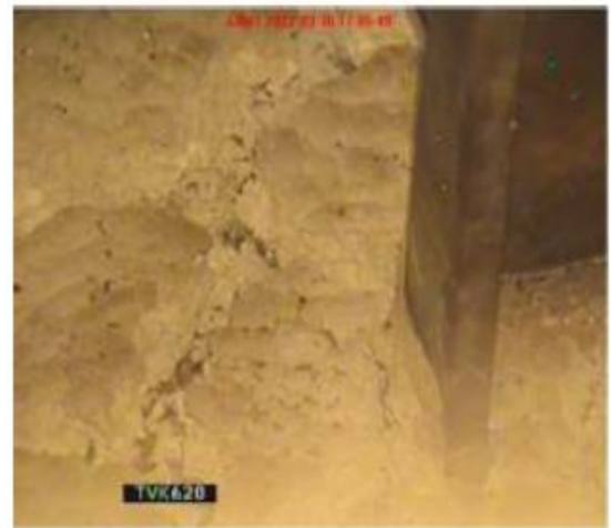
図 3 HAWC タンク底部の残渣物
