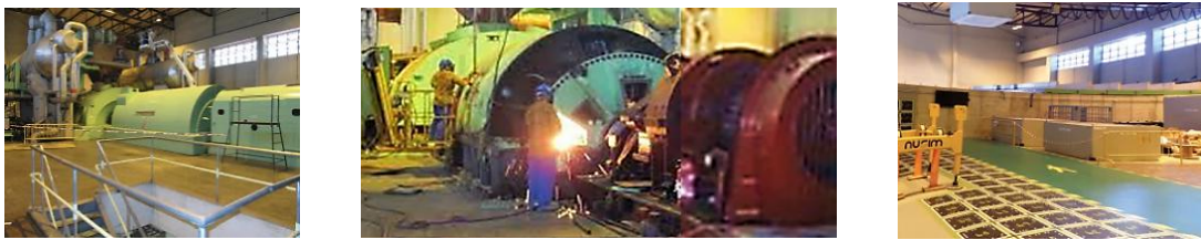
図4 タービン建屋の改修：タービン発電設備、解体撤去作業、廃棄物保管場所
