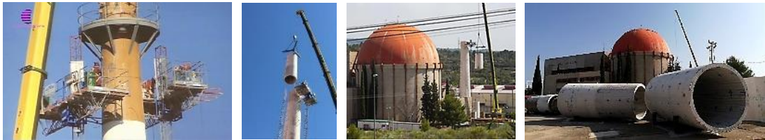
図 8 排気塔の解体撤去、左は最上部の撤去作業
